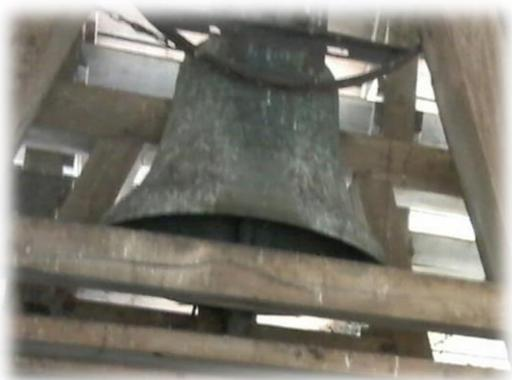
Ils consistent à changer les brides qui, à force d'usure, sont obsolètes. Celles-ci ont provoqué l'endommagement du moteur de volée, de l'ensemble de transmission et pour terminer du battant. Son fonctionnement arrêté depuis le risque de décrochage de l'ensemble des éléments, pourra reprendre dès que les travaux seront terminés. Nous pourrons de nouveau entendre la cloche tinter.
